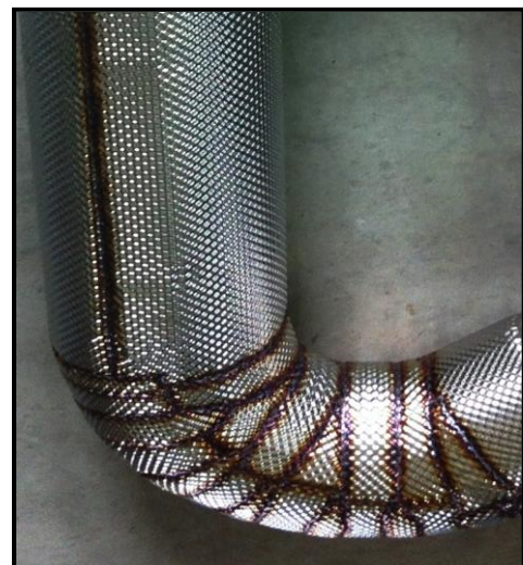
Anlagenbau Folie: 0,15 mm Isolierung: 20 mm
